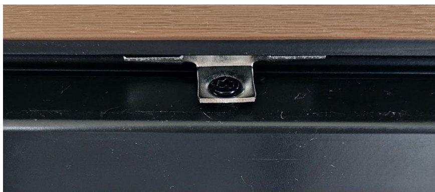
Montáž desky s klipem na nosník
