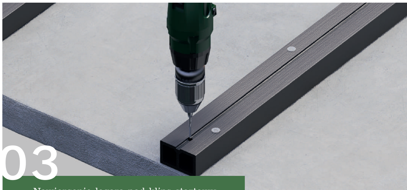
Nawiercenie legara pod klips startowy
