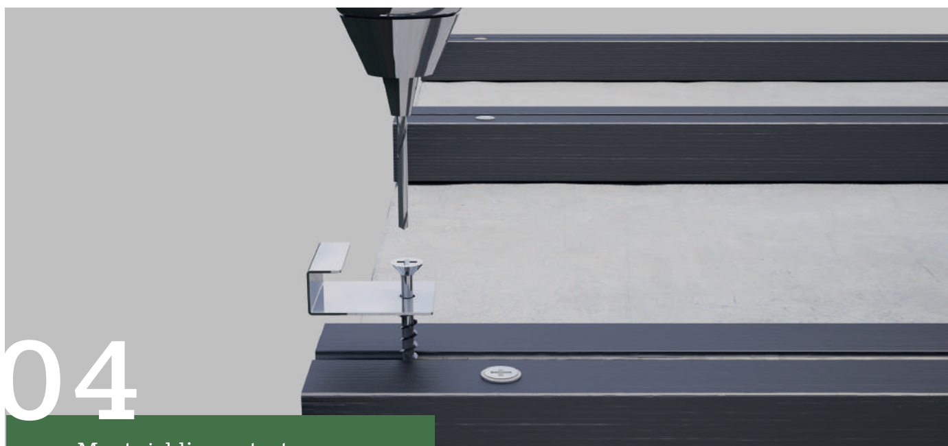
Montaż klipsa startowego
